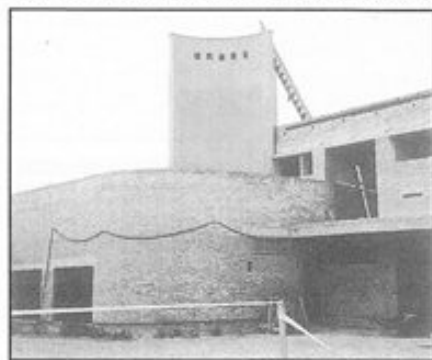
Budynek warszawskiego Zakładu Kremacji MPUK. Stan z czerwca br.
